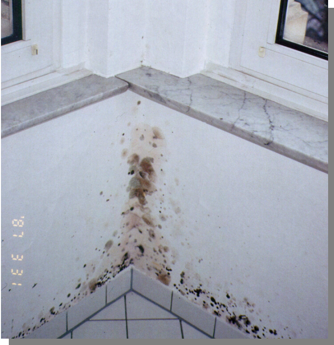
Einbau von neuen Fenstern, ein Jahr nach "Sanierung", Foto Brandhorst
